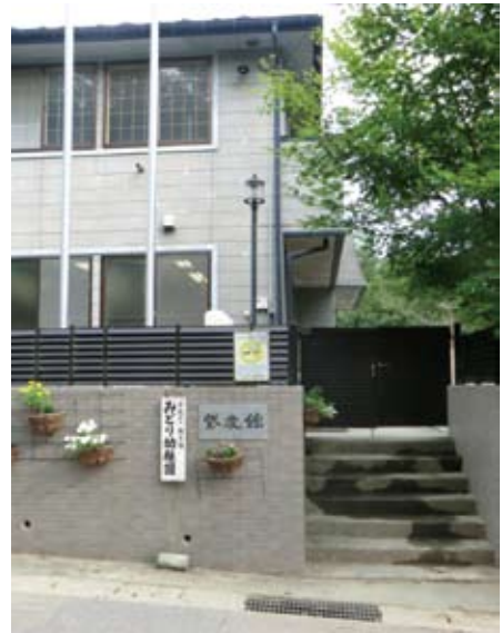
【同窓会館（紫友館） に設置された幼稚園の仮園舎】
