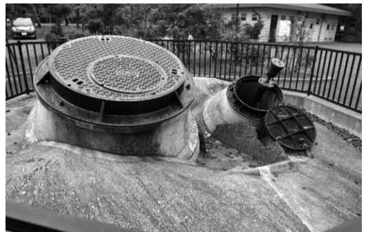
写真3 液状化被害
